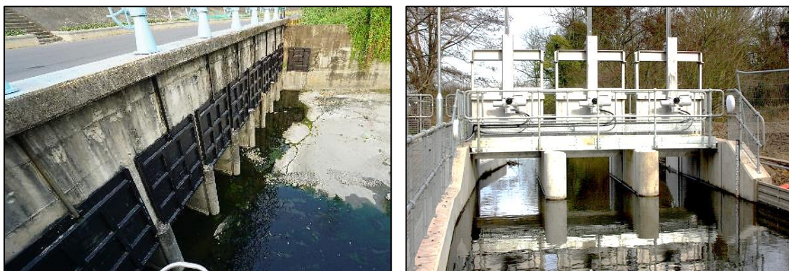
圖 3.1-1 啟閉式閘門堰示意圖
