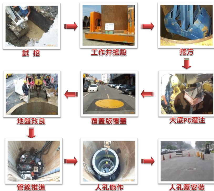
圖 3.7-1 短管推進工法流程圖
