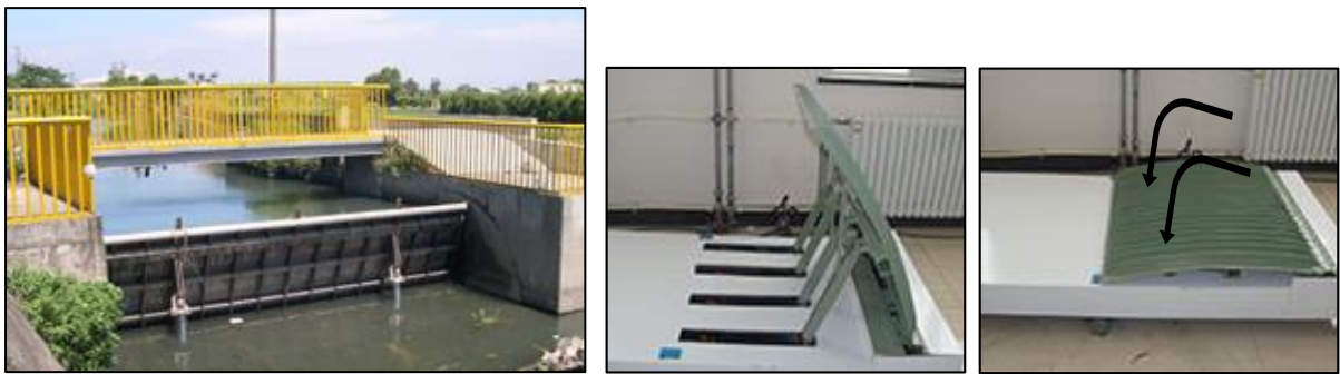
圖 3.1-2 倒伏式閘門堰示意圖
